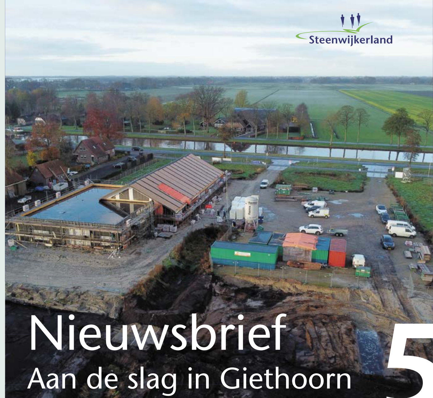
De school in aanbouw
