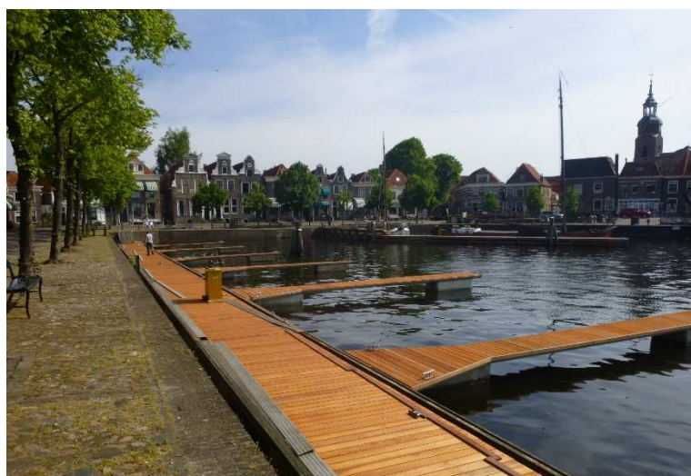
Vervangen drijvende steiger in Blokzijl
