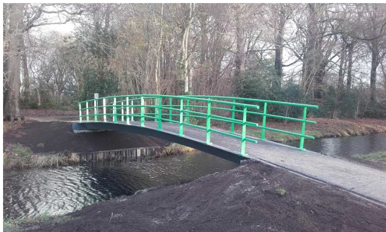
Brug STBV61: de houten brug is vervangen door een composiet brug
