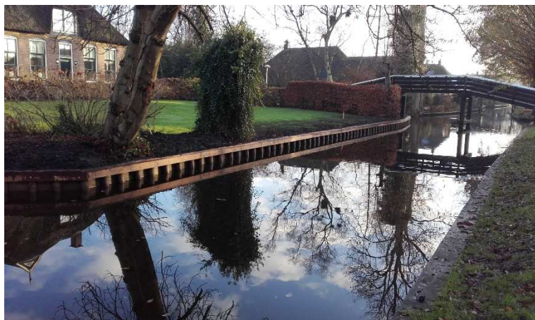
Vervangen beschoeiing dorpsgracht Giethoorn.
