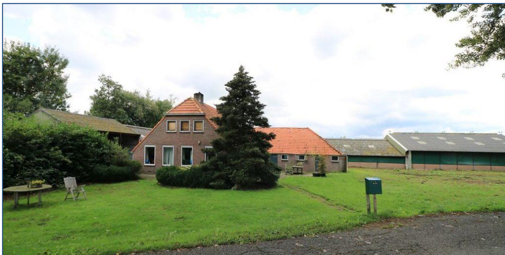
Fig. 2.4: De boerderij op het perceel Zomerdijk 12 te Wanneperveen. De bebouwing achter de boerderij is inmiddels gesloopt. Ook de boerderij is nagenoeg volledig gesloopt.
