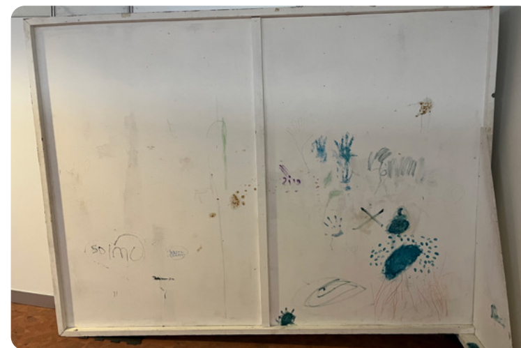
Figuur 13: De schotten in deze noodopvang zijn niet stevig. Verschillende ouders en kinderen vertellen tijdens gesprekken met de Onderzoeksraad dat deze schotten zijn omgevallen tijdens het spel van enkele kinderen (bron: Onderzoeksraad voor Veiligheid).
