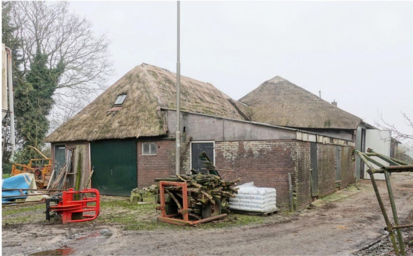
Te slopen aanbouw bij de boerderij
