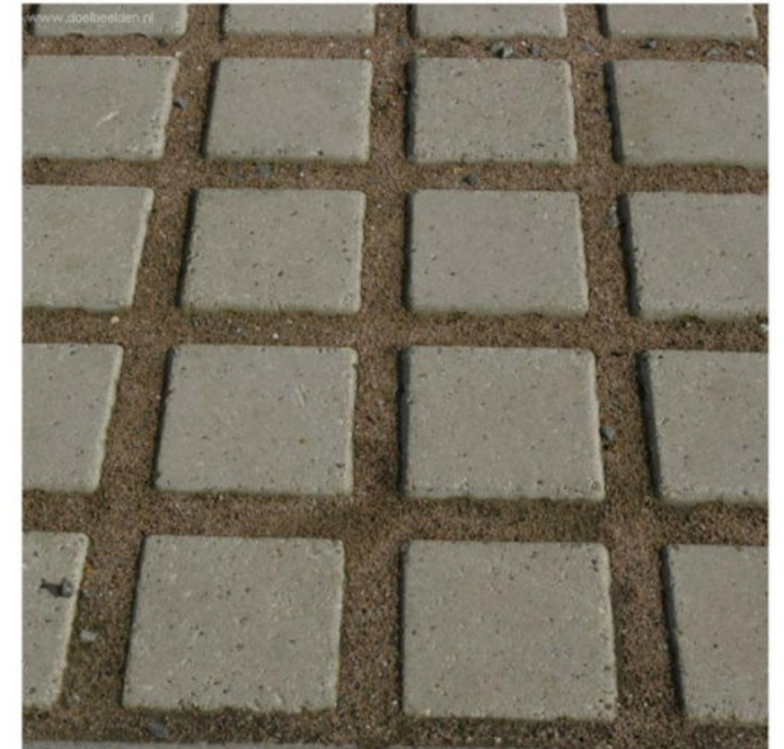
Grasbetonstenen (opstelplaatsen voor containers)
