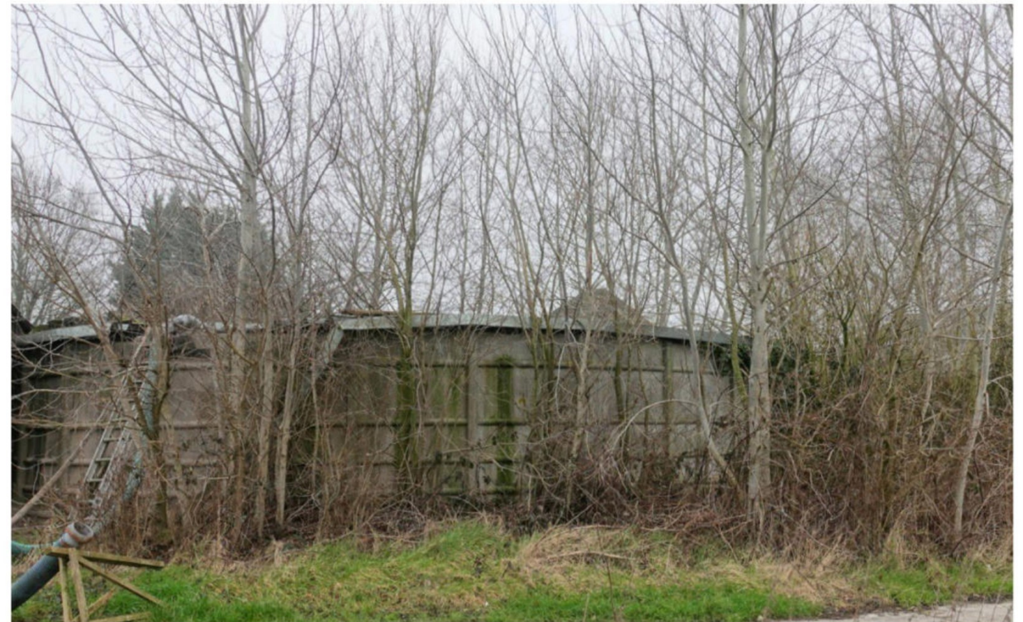
Te slopen mestlo
