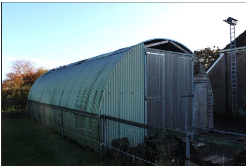
Figuur 5: Schuur ter sloop.
