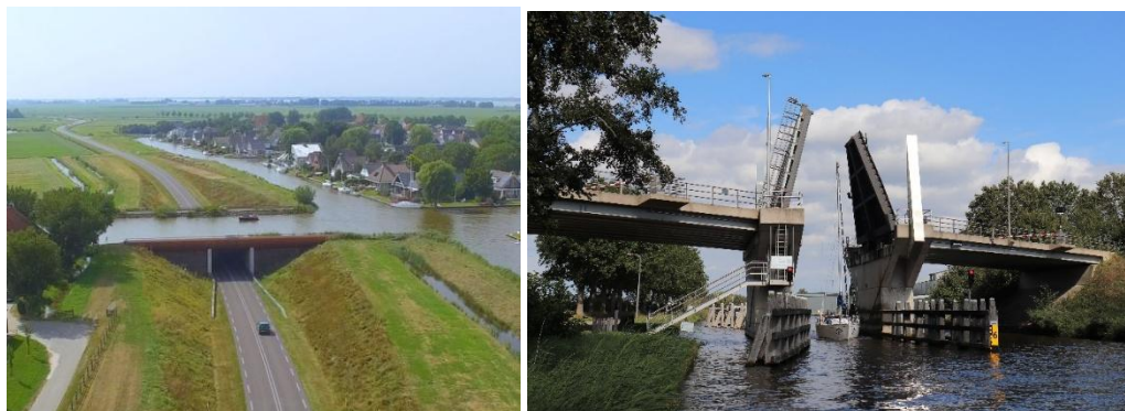
Figuur 5.1 le-aquaduct Woudsend en brug Heerenburg Steenwijk
