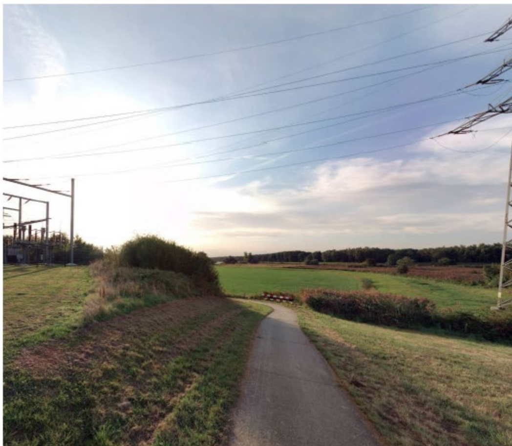
Figuur 3.4 Zicht vanaf de westzuidkant van het transformatorstation [bron: Landschappelijk inpassingsplan, Bijlage 1 van de toelichting]
