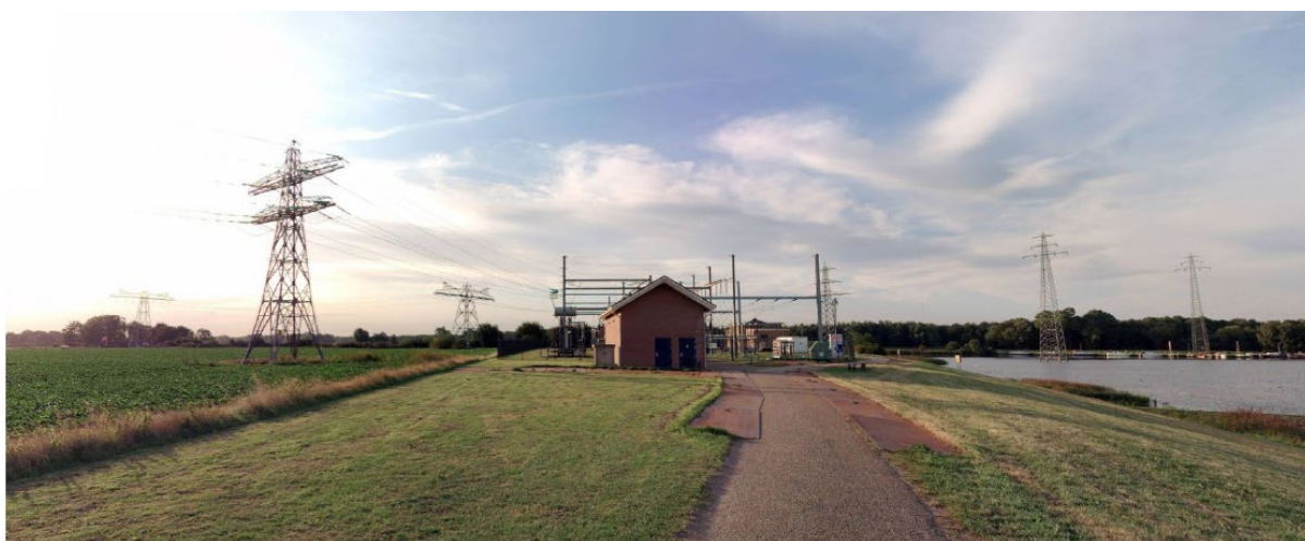
Figuur 3.2 Bestaande transformatorstation gezien vanaf het noorden vanaf fietspad De Voorst [bron: Landschappelijk inpassingsplan, Bijlage 1 van de toelichting]
