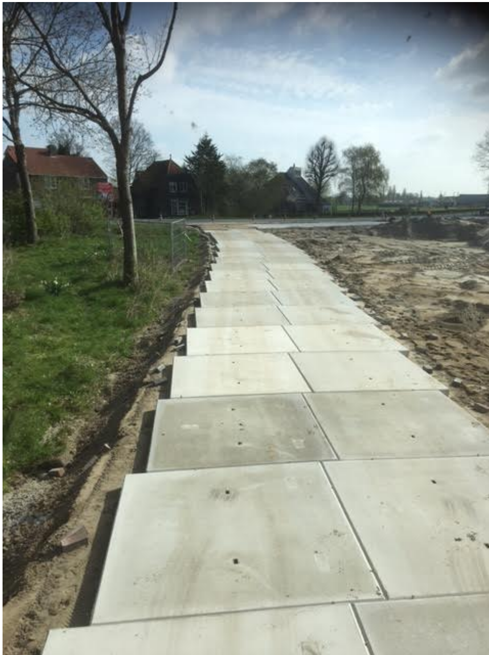
referentie tijdelijke bouwweg met stelconplaten
