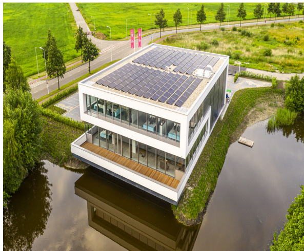
Zon op kantoordak
