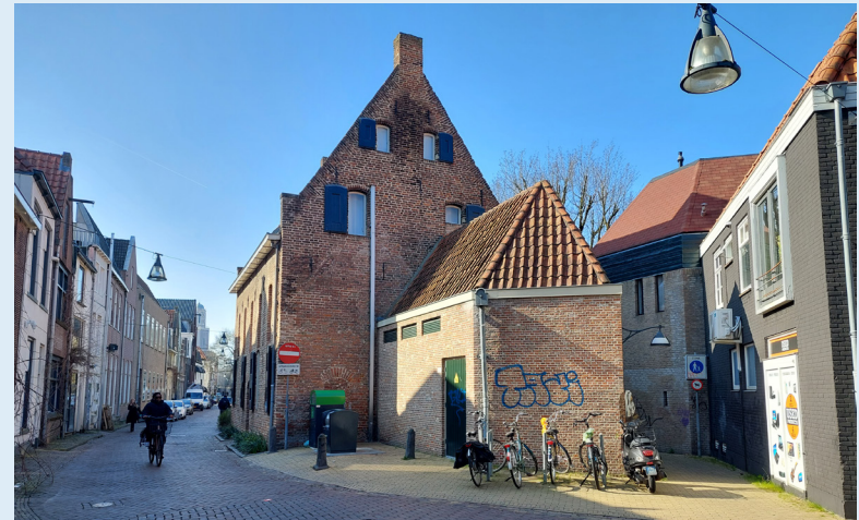
object ingepast als bouwwerk in de binnenstad (Nieuwstraat)
