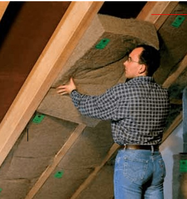
Vlasisolatie Geplaatst tussen sporen
