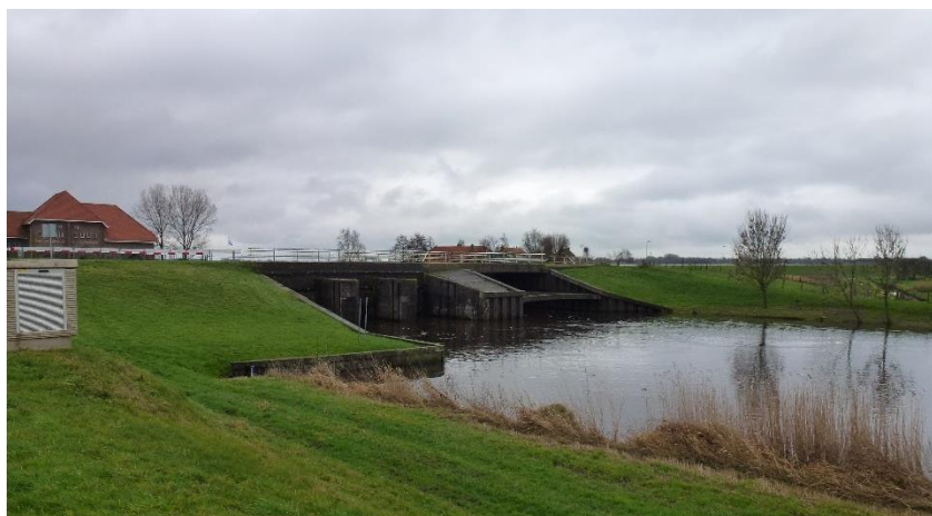
Figuur 7 Brug nabij gemaal Stroink
