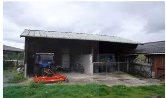
Afdak met damwandplaat bij schuur 2
