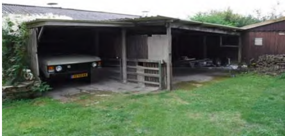
Afdak met damwandplaat
