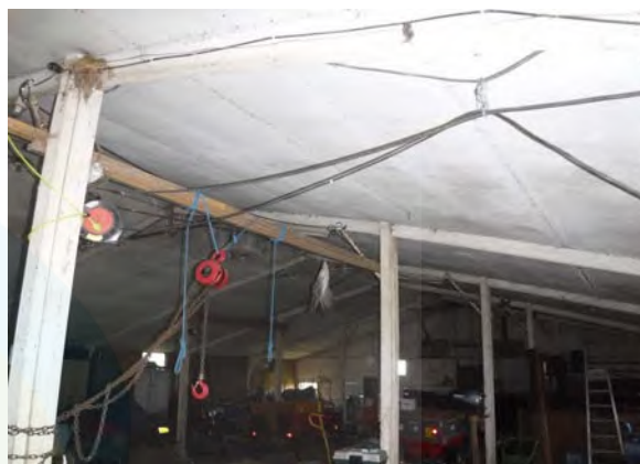
Asbesthoudend plafond schuur 2
