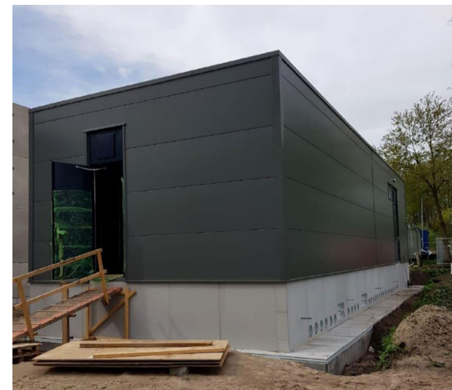
Figuur 20: Voorbeeld modulairgebouw met kabelingangstrook
