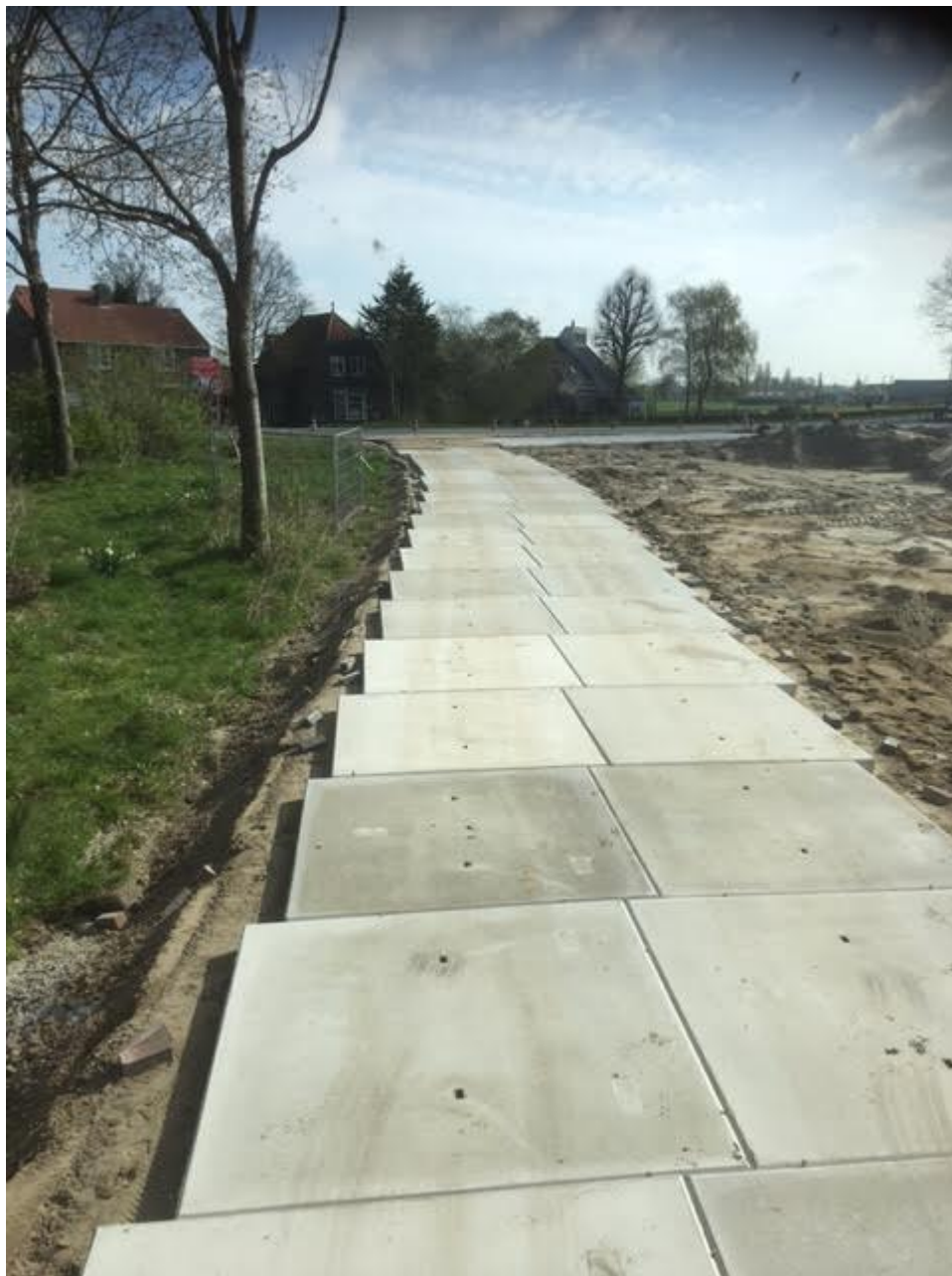
Referentie tijdelijke bouwweg met stelconplaten
