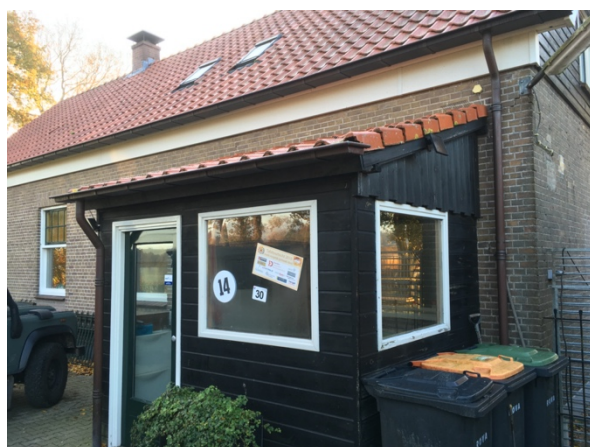
Figuur 7 Noordzijde woning.
