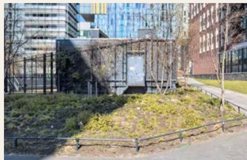
3.46 Zuiderspoorstraat Rotterdam onderstation met groene gevel.
