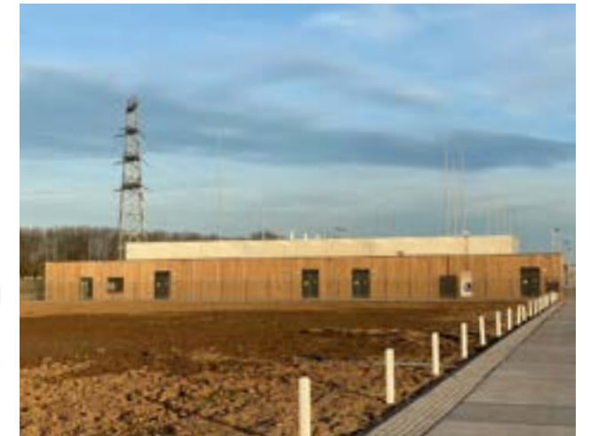
3.28 Oosterhout Nijmegen 150/20 kV onderstation.
