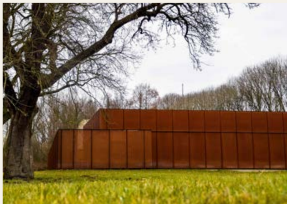
3.42 & 3.43 Utrecht schakelstation met MD strekmetaal van corten.
